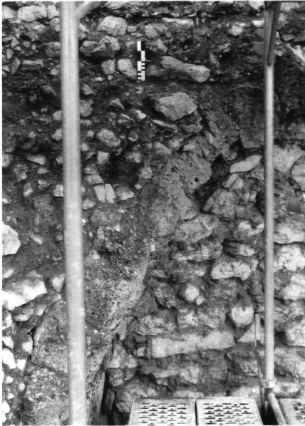
6: Ebauche sud de la voûte en blocs de tuf et face intérieure rougie au feu du mur M1 avec des restes du mortier d'origine; vue de l'E.
