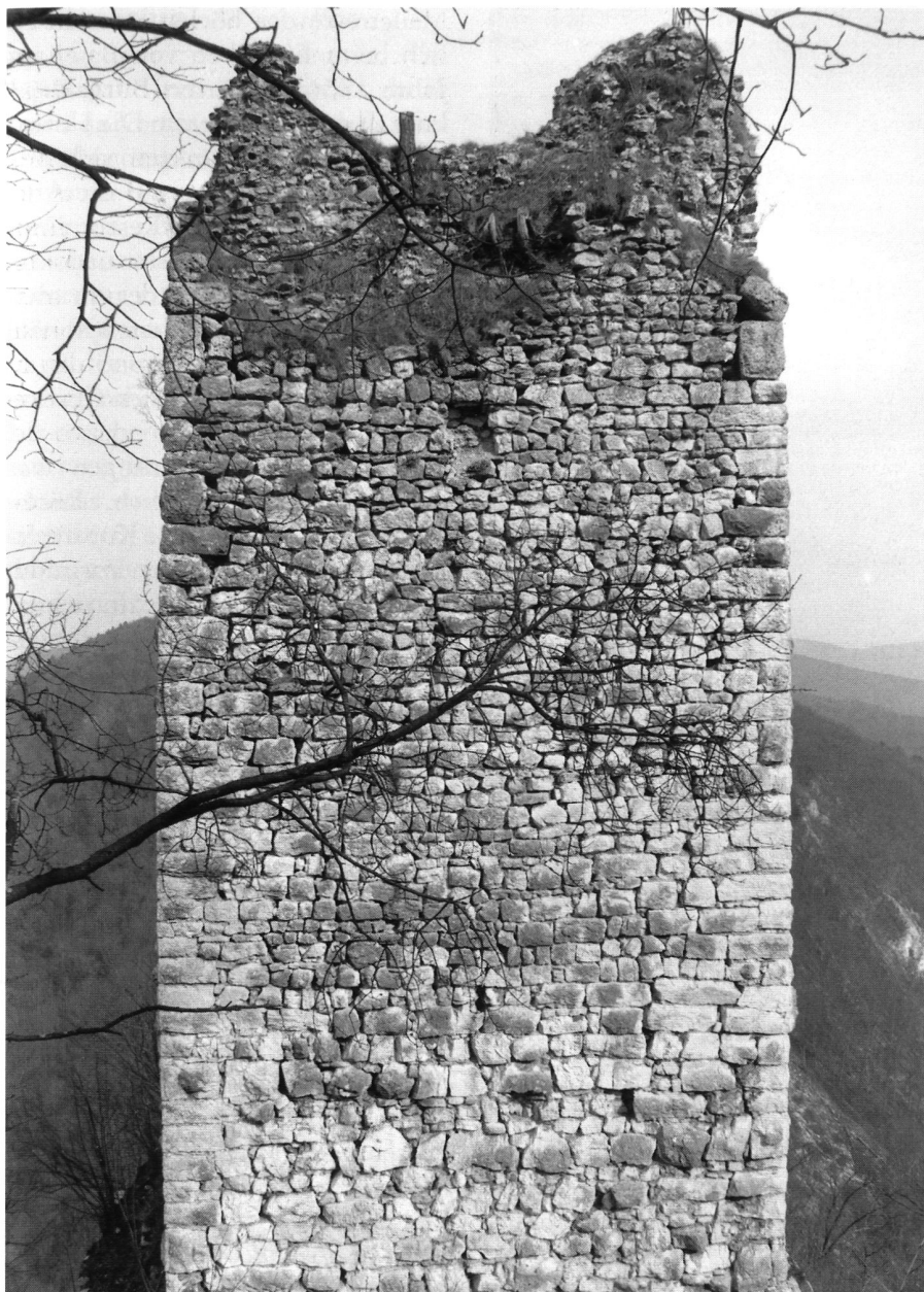
17: Mur M1. La face ouest du château, conçue comme mur bouclier étroit et élevé. La déformation en forme de tonneau du mur est bien reconnaissable; vue de l'W.
