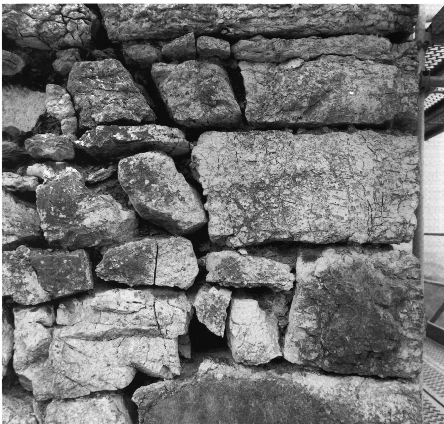
10: Arête des murs M1/M7. Chaîne d'angle construite en gros blocs calcaires; vue de l'W.
